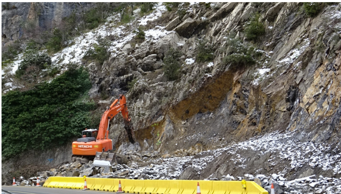
Treballs preparatoris per a l'execució del túnel
