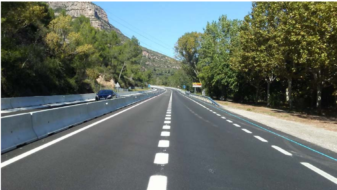
Estat actual de la carretera amb el tercer carril.
