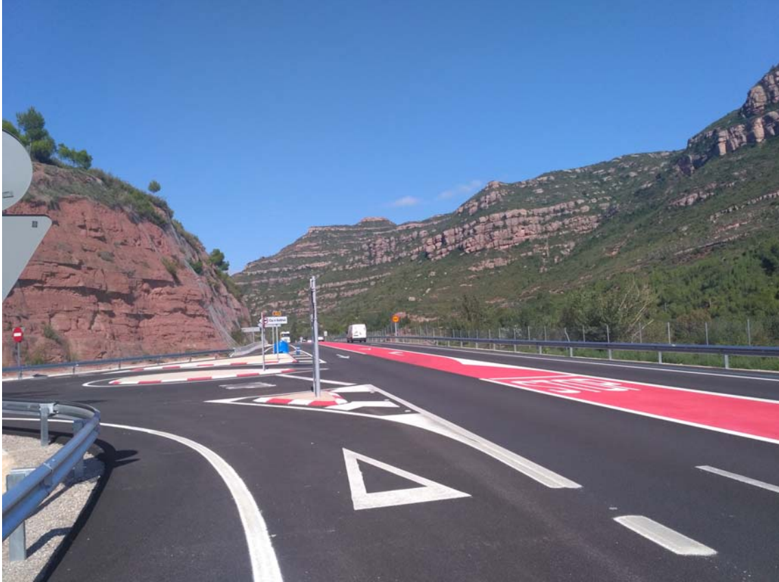
L'encreuament de la C-55 amb la B-113.
