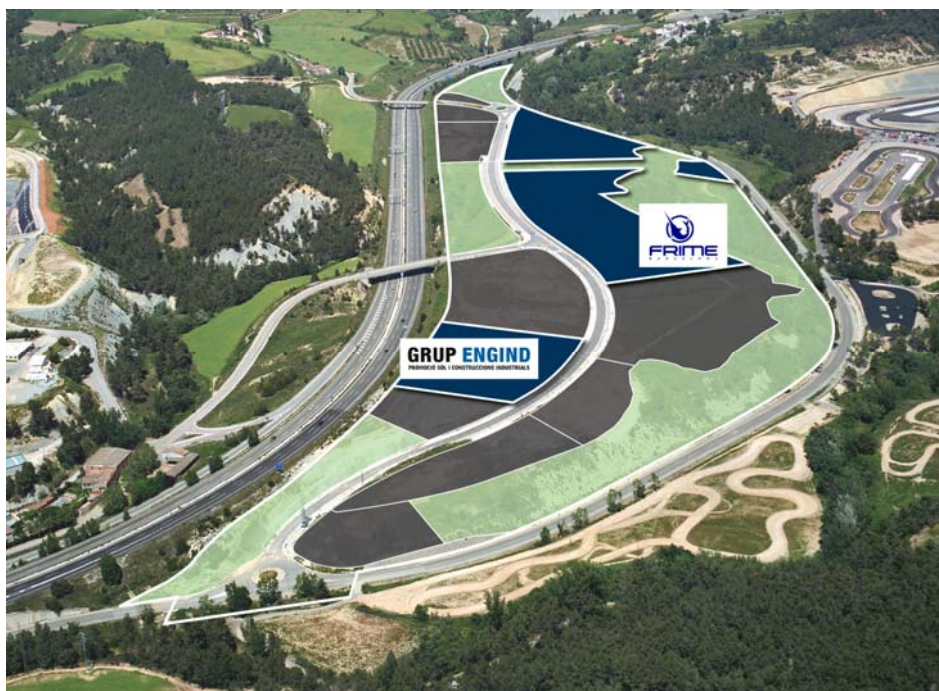
Parcel·les on s'instal·laran les empreses FRIME i ENGIND a Can Parera, Castellolí.
