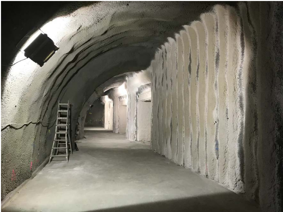
La galeria excavada per poder aixamplar l'andana.
