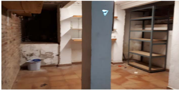
Vistes dels magatzems, lavabos i dipòsit de gas
