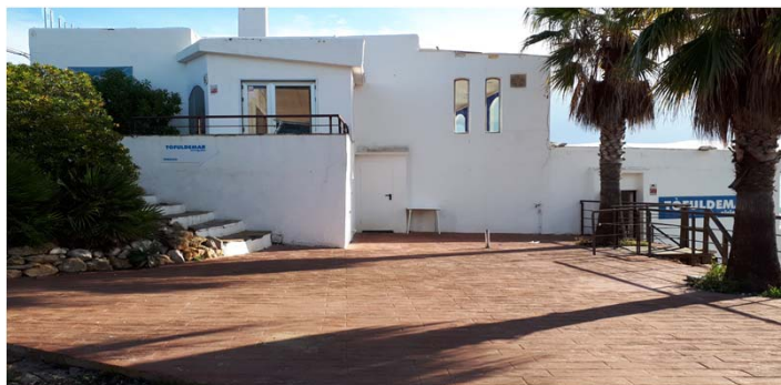
Vistes de les dos terrasses exteriors i de la coberta
