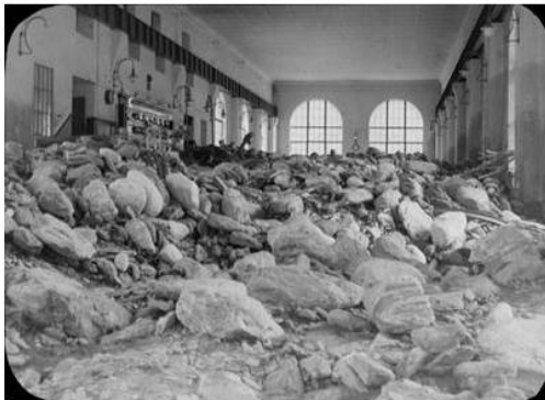
Danys a l'interior de la Central Hidroelèctrica de Capdella, causats per les inundacions d'octubre de 1937
