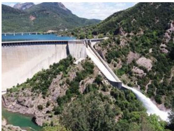
La presa de la Baells alliberant 42 m 3 /s a través del sobreexidor.
