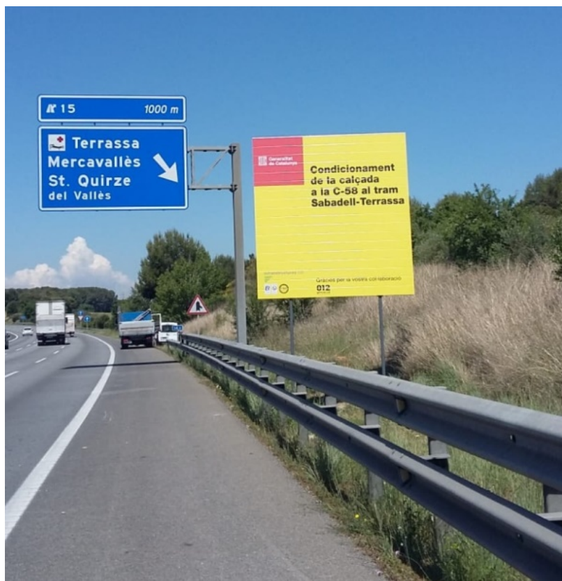
Tasques prèvies de l'obra de condicionament
