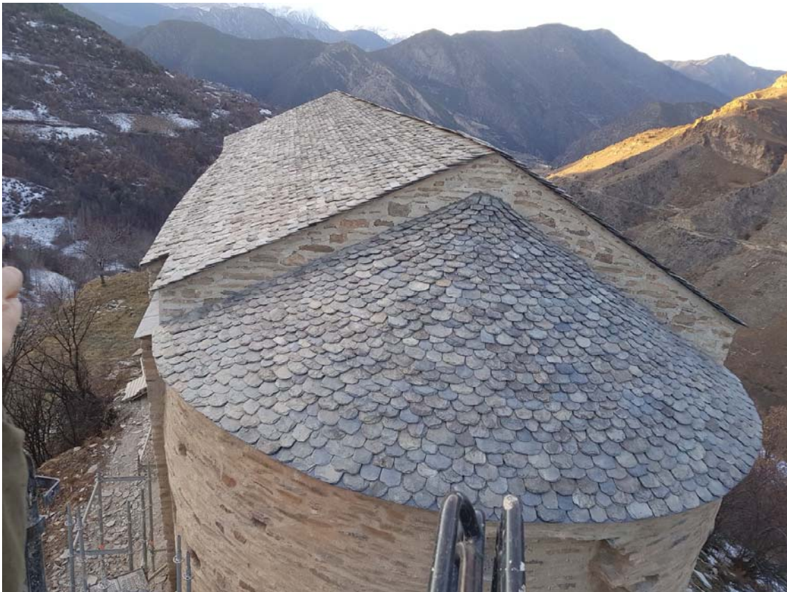
Vista de la teulada de l'ermita restaurada.
