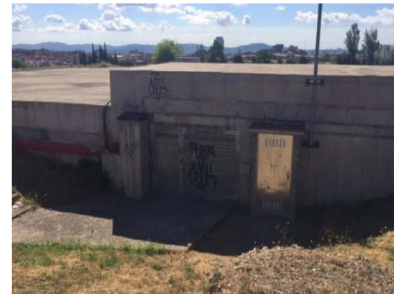
Rehabilitació dipòsit Can LLong
