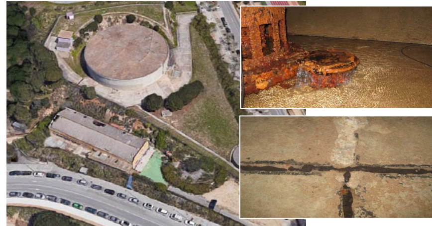
Rehabilitació dipòsit c180 Mataró
