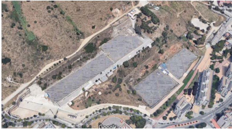
Estació distribuïdora Trinitat. Rehabilitació Fases II, III i IV
