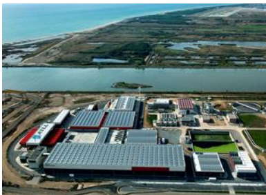
Vista aèria de la dessalinitzadora del Llobregat.
