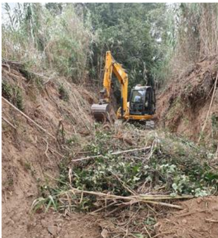
Treballs al torrent de Mas Blanc, a la Selva del Camp.
