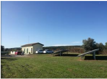
La planta disposa de 36 panells amb una potència de 10 kW.
