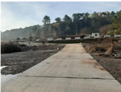
La zona de la passera, després dels treballs.
