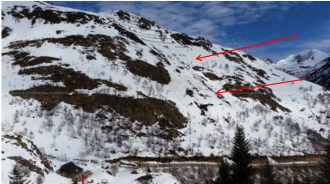
Fileres de paraallaus col·locades actualment; les fletxes assenyalen la zona on s'instal·laran les noves barreres
