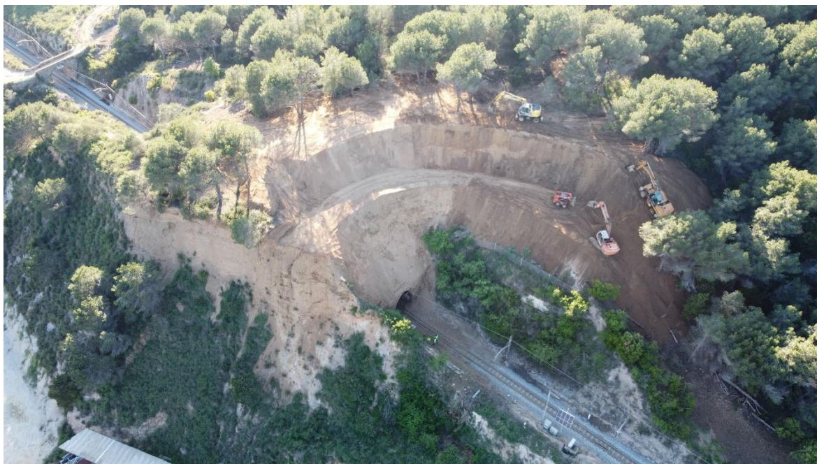
Vista aèria d'obres a les línies d'FGC.
