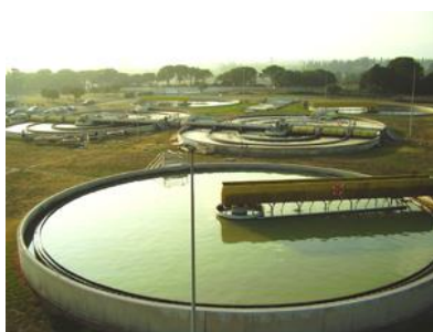
Depuradora de Cambrils.
