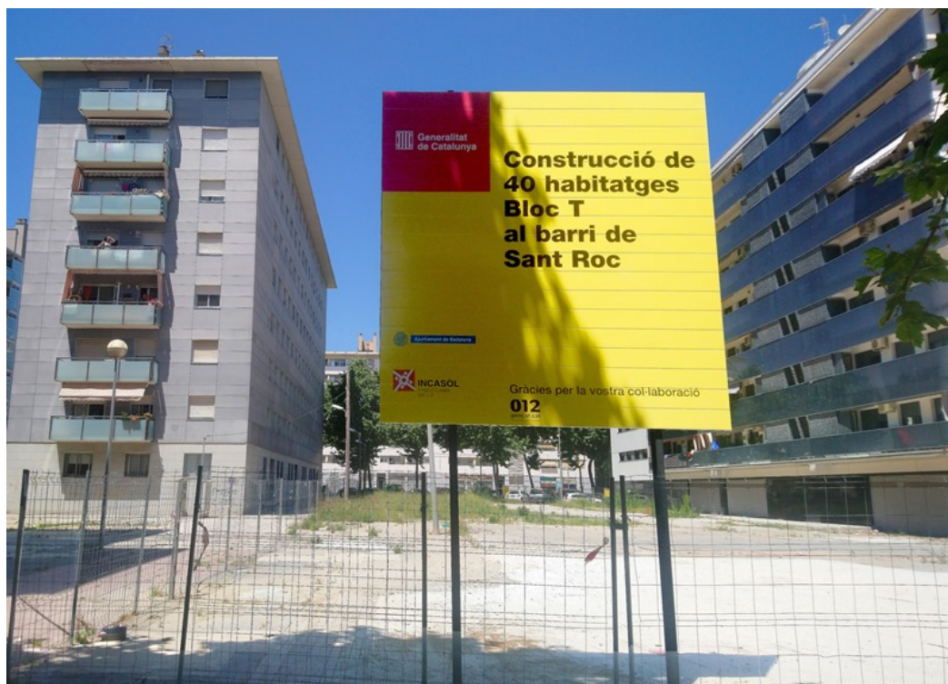
Solar on s'han iniciat les obres de construcció del Bloc T al barri de Sant Roc de Badalona.
