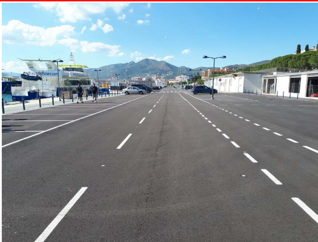
Pavimentació de l'esplanada del moll de ribera del port de Roses
