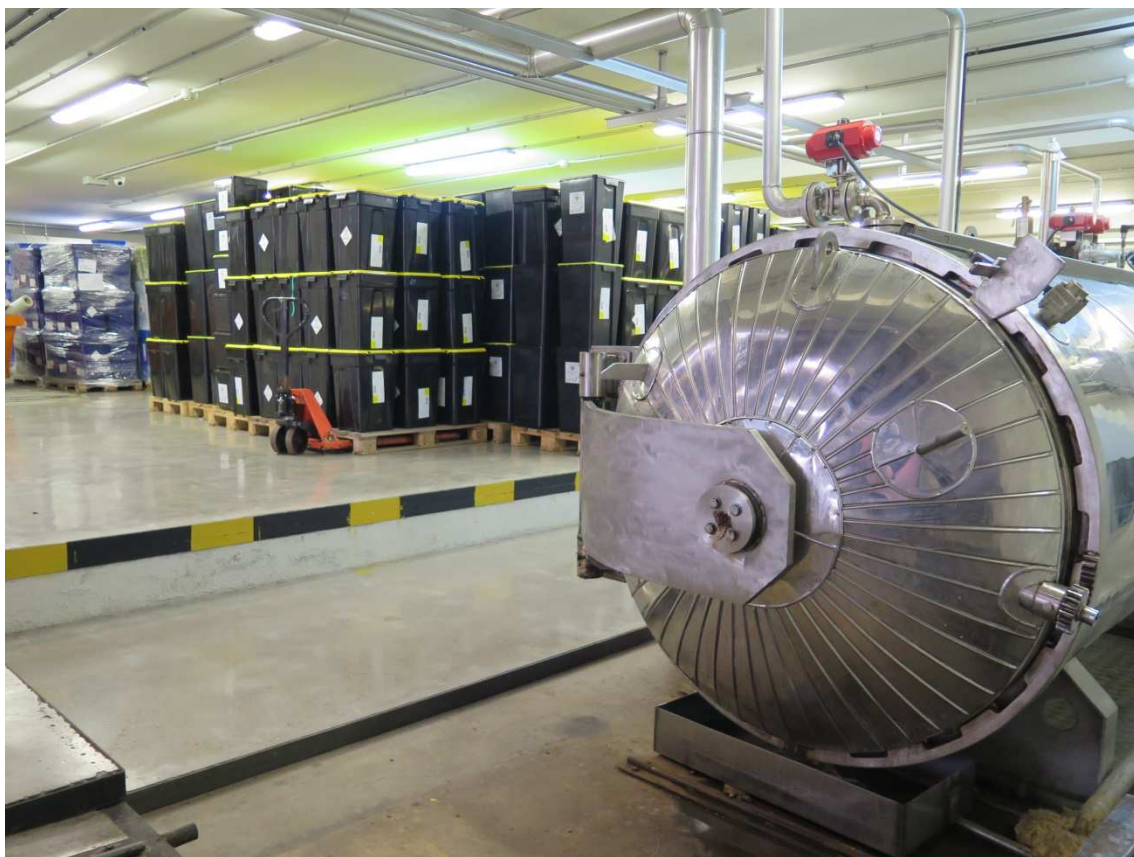
Contenidors sanitaris i maquinària per al procés d'autoclau.
