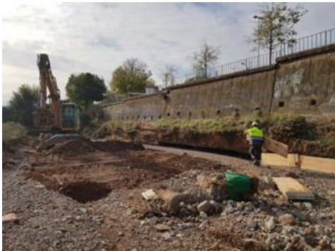
Treballs de reparació dels murs de la riera de les Arenes, a Terrassa (arxiu).
