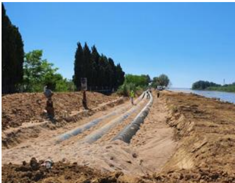
Tasques de cobriment de les canonades reparades.
