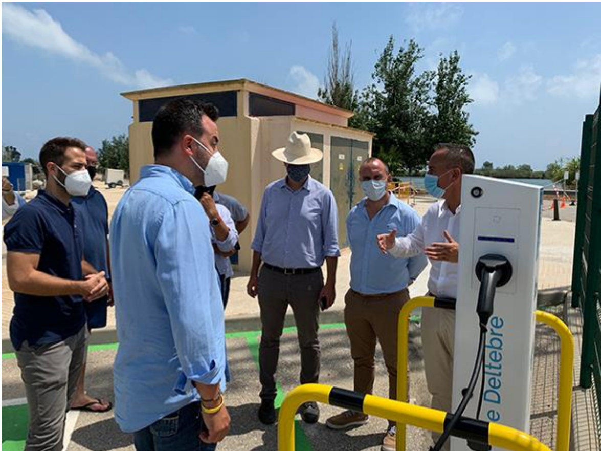
Posada en servei del punt de recàrrega de vehicles elèctrics al port de Deltebre.
