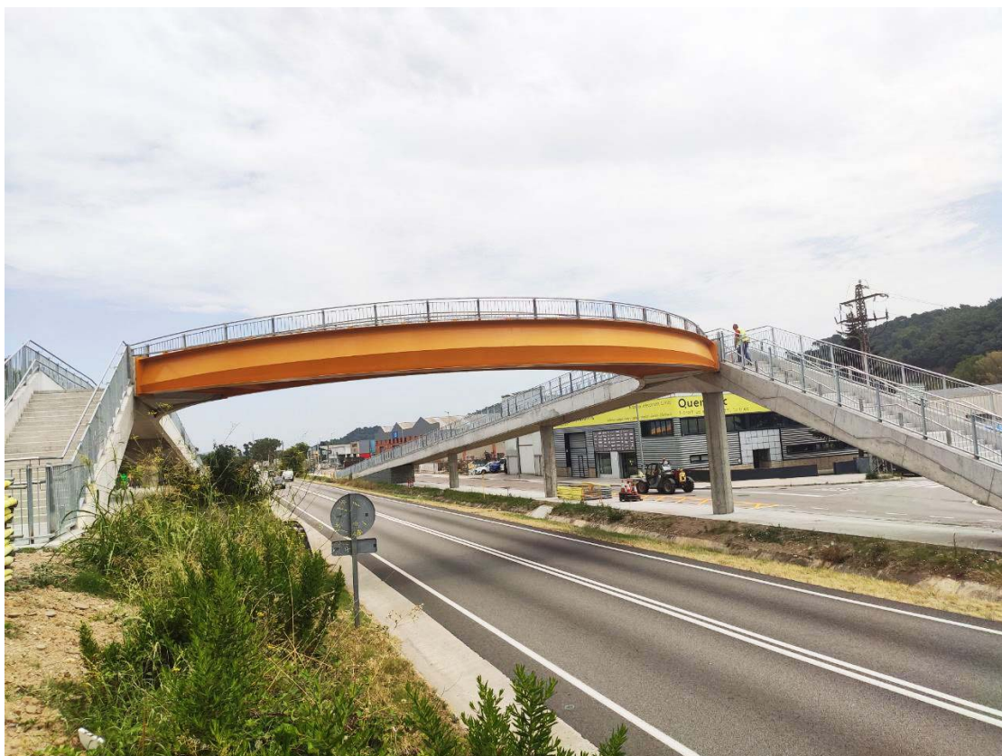
La nova passarel·la sobre la C-35, que s'ha obert aquest migdia
