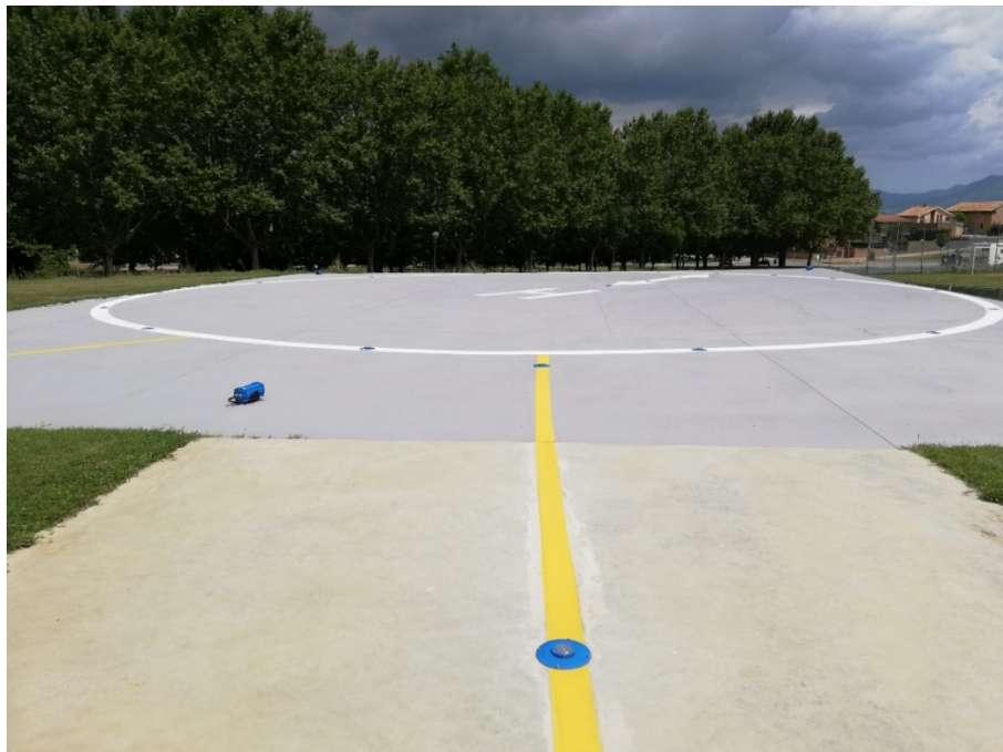
Imatge de l'heliport amb les obres a la infraestructura acabades
