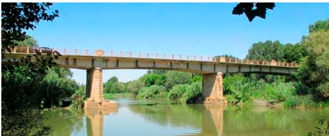
Pont de la C-252 sobre el riu Ter a Verges
