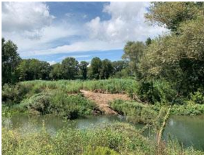
Tram del riu Fluvià després de l'actuació.
