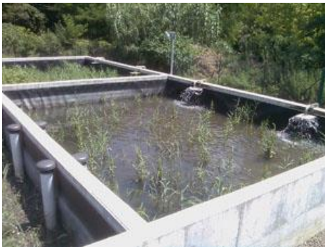
Detall d'una depuradora (arxiu).
