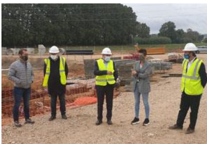
Autoritats durant la visita a les obres d'ampliació de la depuradora de Maçanet.
