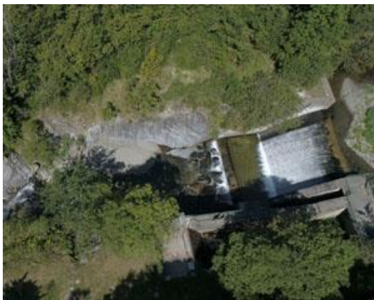
Vista aèria de la minicentral que es desmantellarà.
