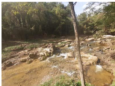
La riera de la Gavarresa, al Molí de la Coromina, després de la primera actuació duta a terme.
