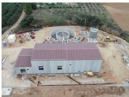
Vista aèria de les obres de la nova depuradora del Botarell.
