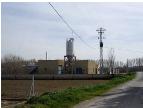
Exterior de la depuradora d'Alcarràs.
