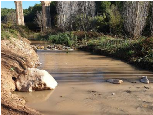
Tram del riu Gaià durant les maniobres de cabals generadors.
