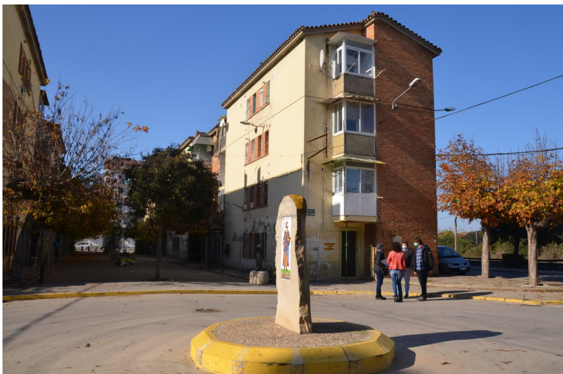
Acte d'inici de les obres d'enderroc del Bloc A del Grup d'habitatges Sant Isidori, a Mollerussa.
