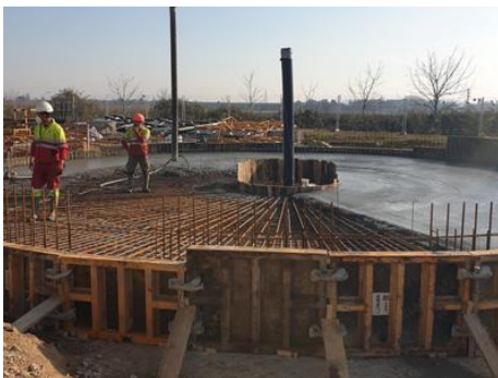
Treballs per construir la nova depuradora de Torrefarrera.
