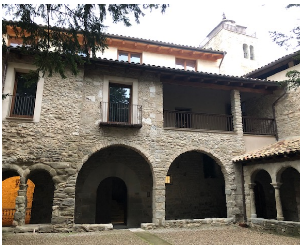
Rehabilitació de la capella que dona al claustre
