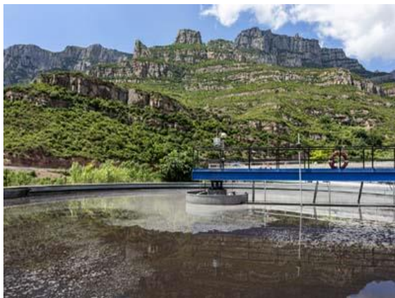
Detall de la depuradora de Monistrol de Montserrat, després dels treballs de millora.
