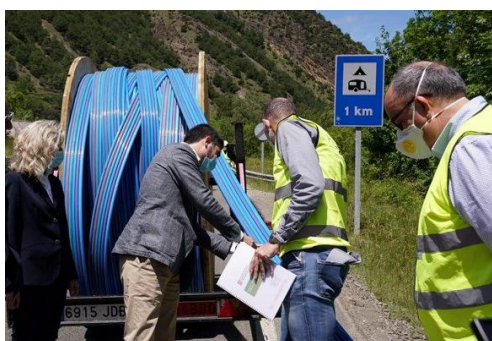
Visita obres de fibra òptica Sort-Alt Àneu (Juny 2020)
