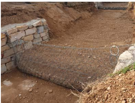
Al barranc de Matamoros (Roquetes) s'han instal·lat malles de retenció i s'ha actuat per minimitzar la velocitat de l'aigua.
