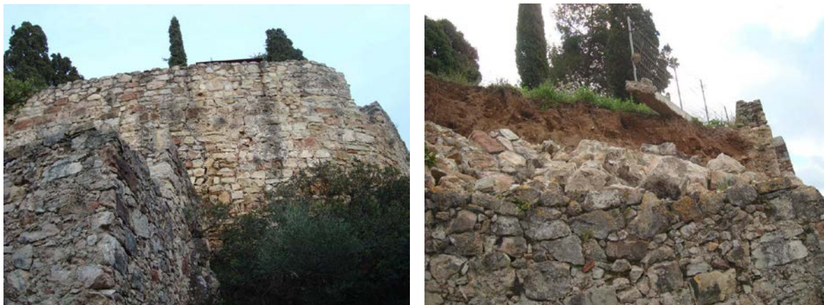
Comparativa de mur i contrafort del castell de Gelida en el seu estat inicial i després de l'esfondrament.
