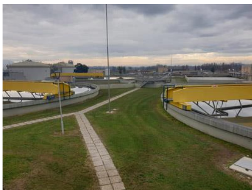
Depuradora de Lleida, al Segrià.
