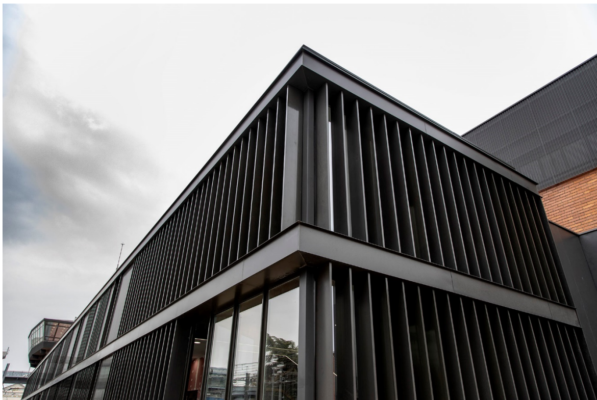
La nova façana de l'edifici s'ha configurat totalment amb revestiments d'alumini.
