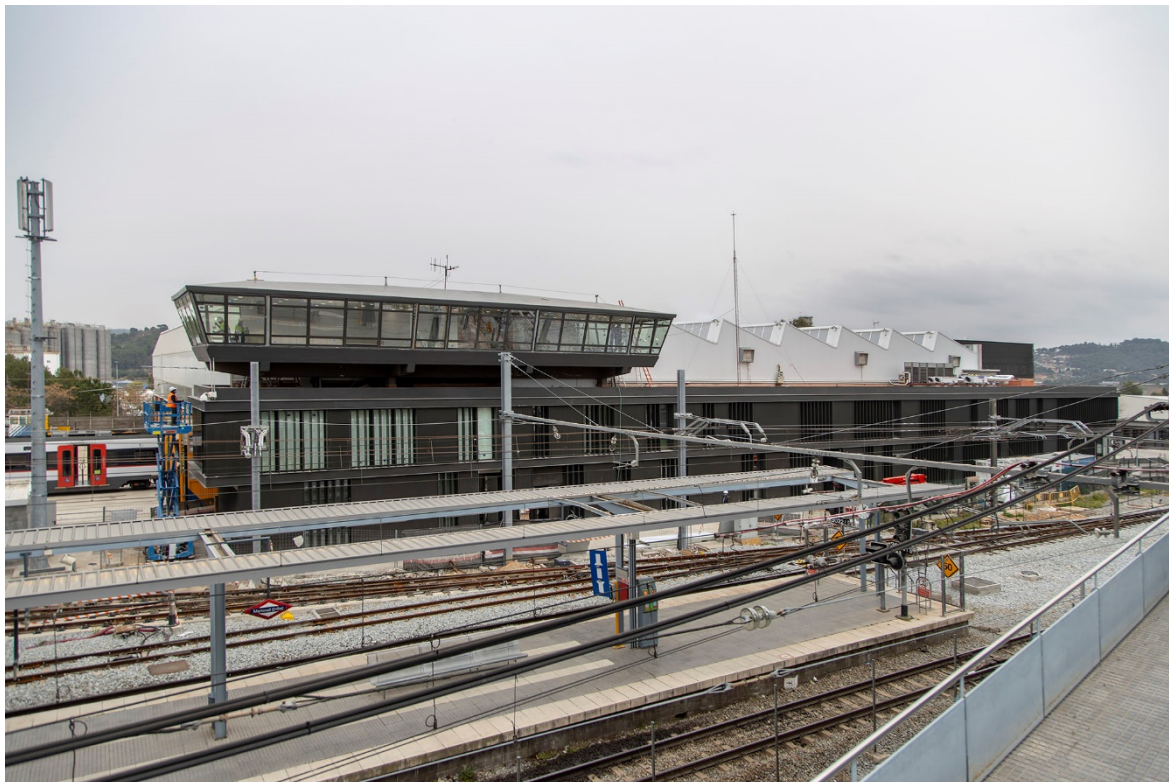
Fotografia genèrica amb la façana principal longitudinal a la via, on es pot observar la volumetria destacada de l'edifici anomenat “La Barca” destinat a dues aules de formació.
