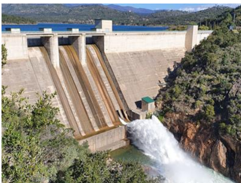
La presa, durant l'inici de les maniobres de cabals generadors.
