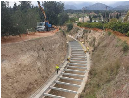
Obres en curs en el canal de l'esquerra, en el municipi de Tivenys.
