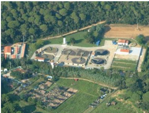
Depuradora de Tossa de Mar.
