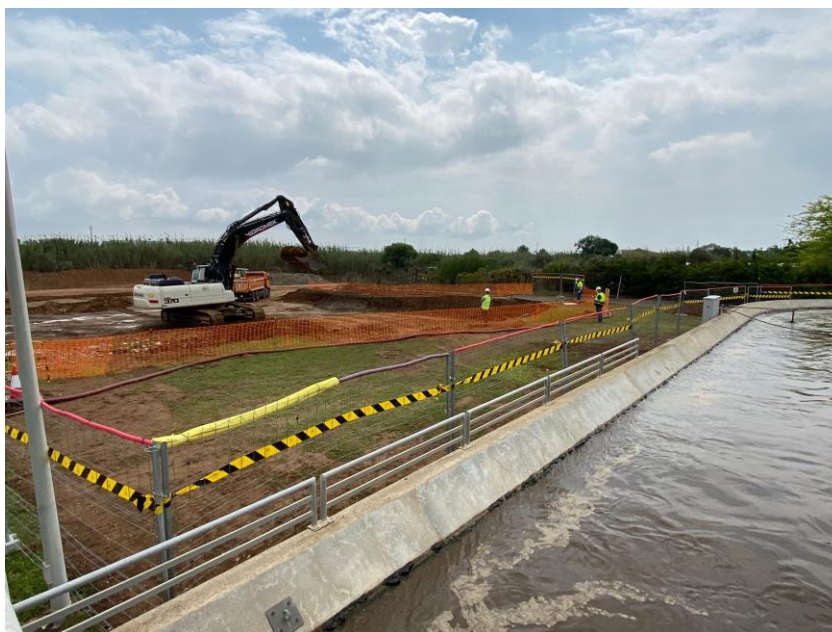
Primers moviments de terres dels treballs d'ampliació.
