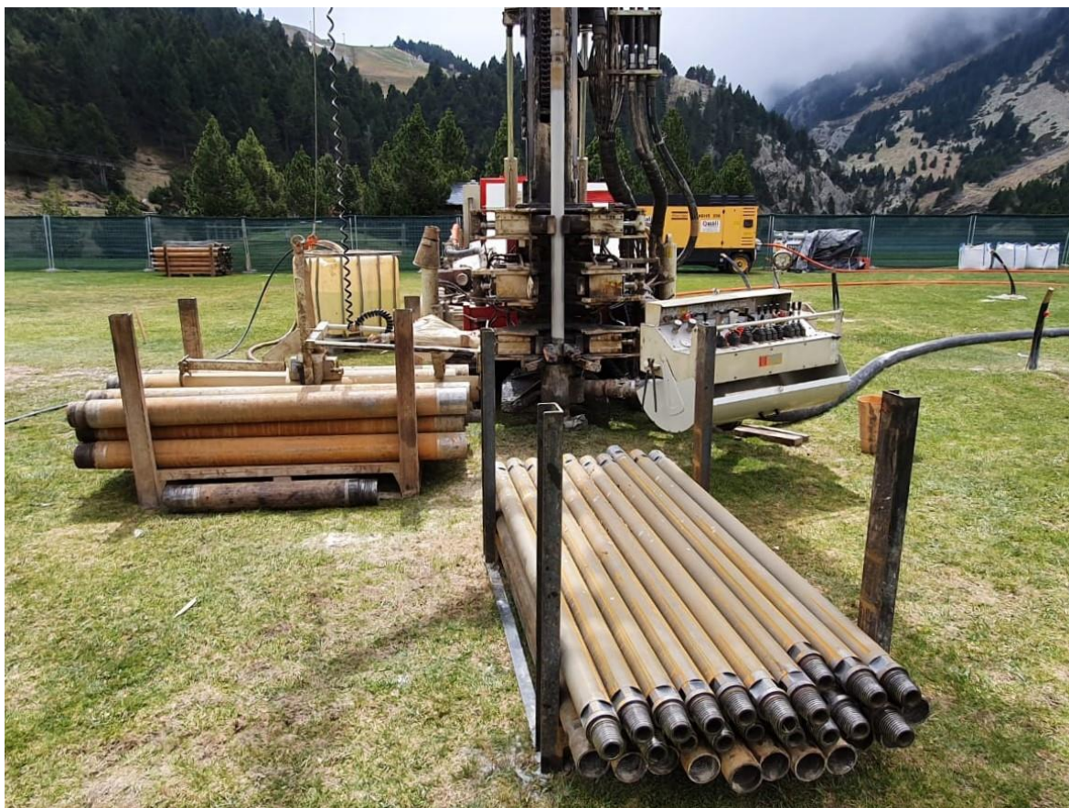
Els 36 pous que s'estan instal·lant generaran 240 quilowatts tèrmics.
