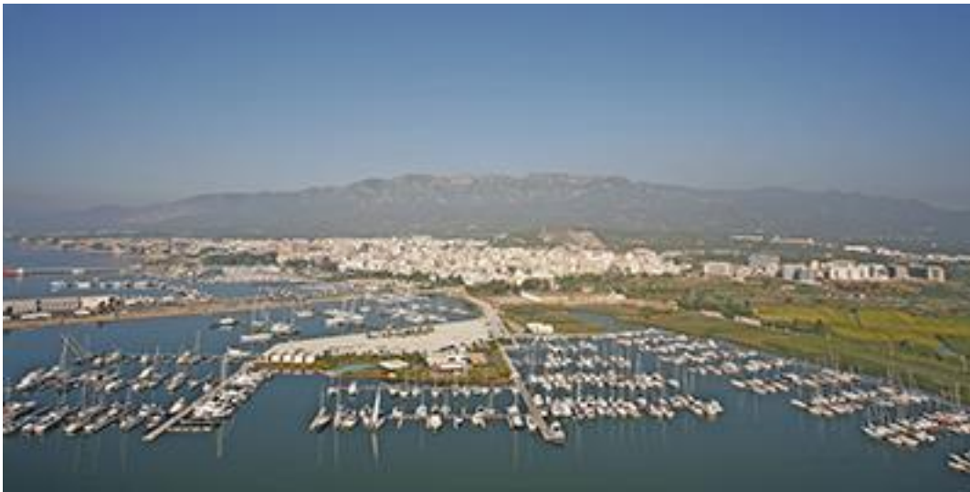
Port de Sant Carles de la Ràpita.
