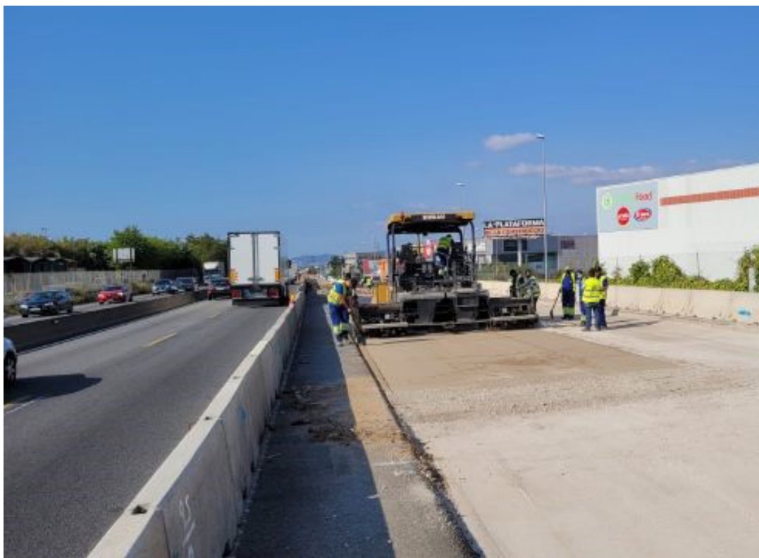
Obres a la C-17
